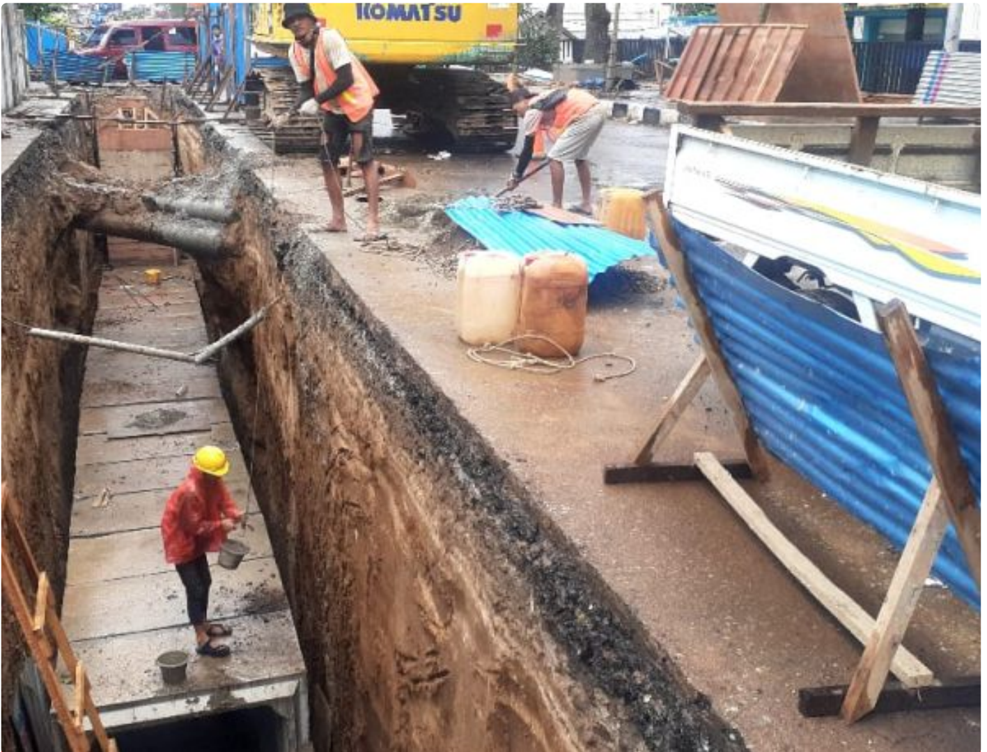
Pekerjaan Drainase Kota Bukittinggi kini telah mencapai 70%
